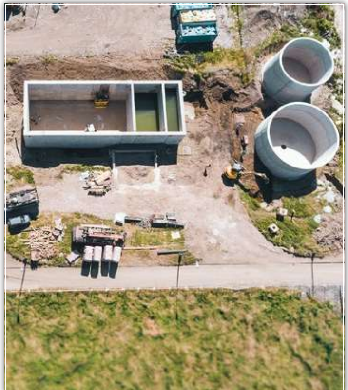
Robbau der neuen Kläranlage bei SlovTan in Liptovský Mikuláš.
